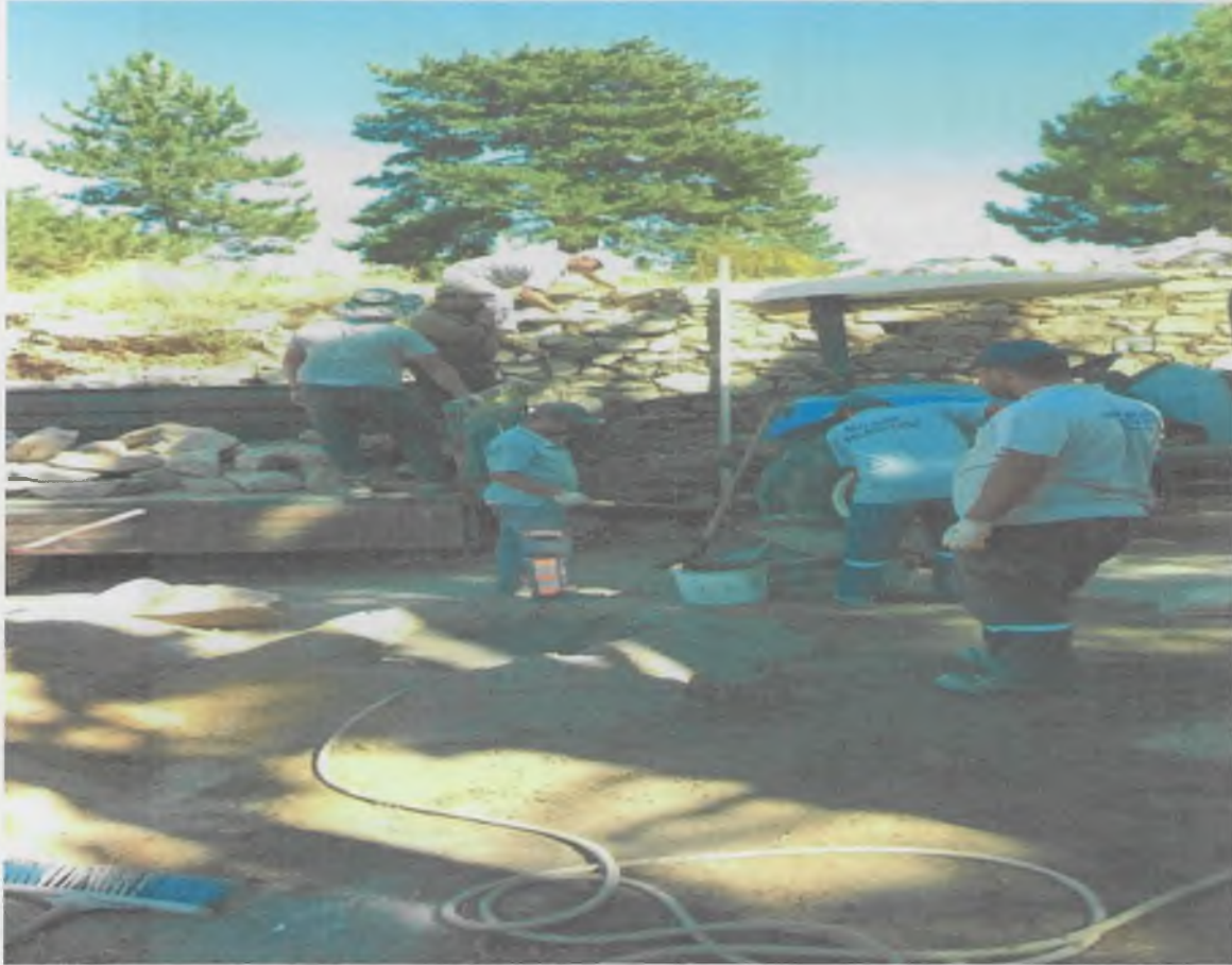
29.İlçemiz Hasanbeyler Mahallesi Körtepe Mevkiinde bulunan sosyal tesisde bulunan binanın kapı ve pencereleri yenilendi .
